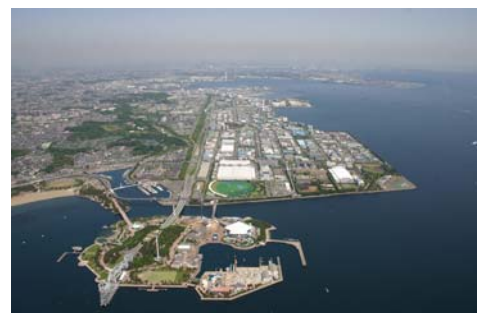
写真-4.1.6 金沢地先埋め立て
